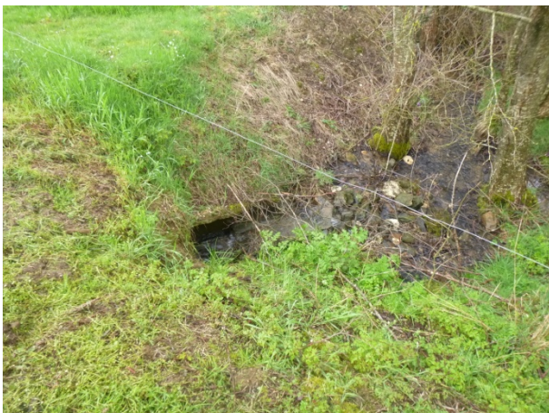
Passage du Thouet dans la digue (dénivelé d'environ 1 m)
